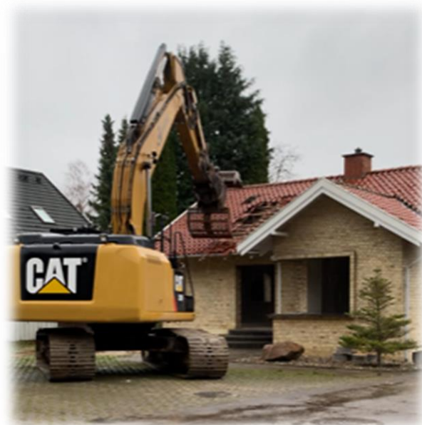
Gamle villa under nedrivning
